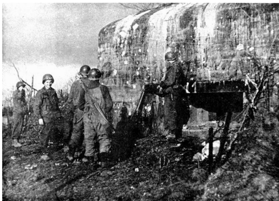
Casemate allemande détruite
